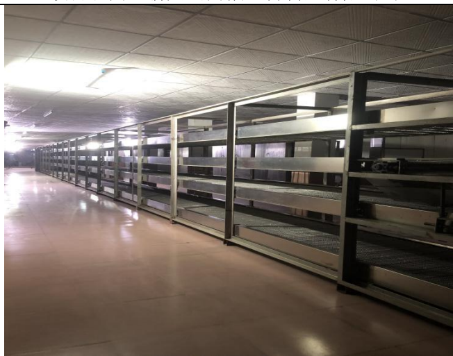
项目现场情况
