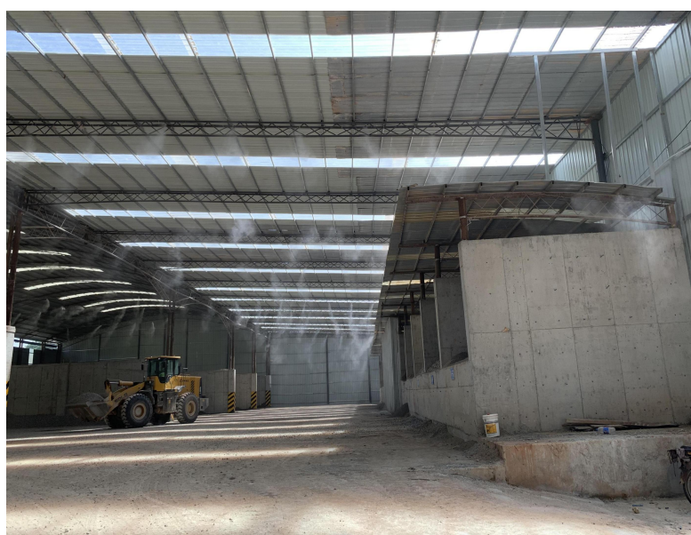
图 4-2 同类项目原料仓库实施封闭和喷雾抑尘（资料图）
